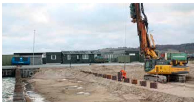
▲ Opfyldning af den inddæmmede del af havnen på Flådestation Frederikshavn er nu så fremskredet, at der kan arbejdes med den indre spunsvæg. Væggen skal virke som anker for den ydre og modvirke, at den kan skride ud ved belastning.
