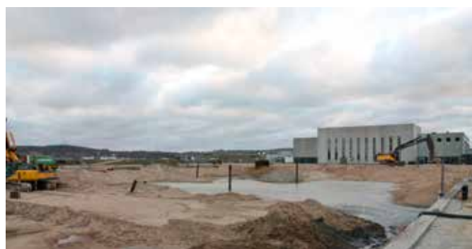
▲ Der er fyldt store mængder af sand og grus i bassinet. Mellem 220 og 300 vogntog kørte hver dag i dagene op til jul materialet ind på Flådestationen. (Foto: Chefsergent Claus Just Gustafsen)
